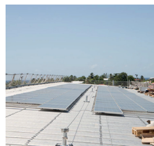
Installation de panneaux photovoltaïques sur le stade pour alimenter la cuisine centrale
