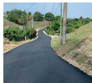
Réfection de la route de Fond Vapeur
