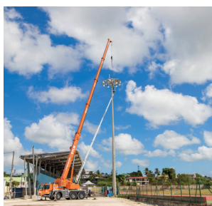
Modernisation des éclairages du complexe sportif de Valette
