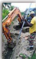
Travaux sur la route du Helleux
