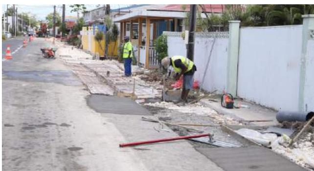
**Travaux d'assainissement:** Le SIAEAG est intervenu à l'angle des rues Dandin et Abbé Grégoire pour réparer à la fois, une fuite sur le réseau d'eau potable et une seconde fuite sur le réseau d'assainissement
