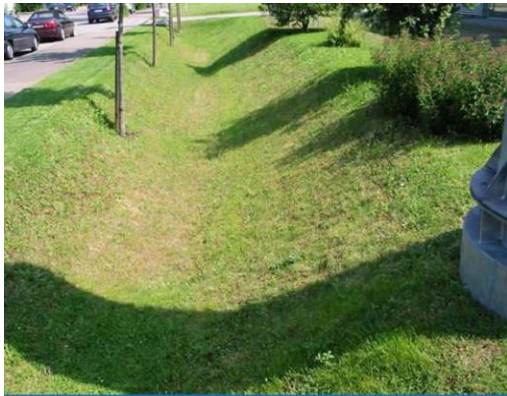
Figure 3 Photo et coupe typique d'un noue pluviale
